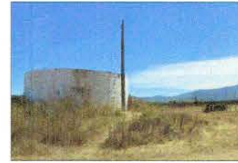
Vista de copa de agua existente.
